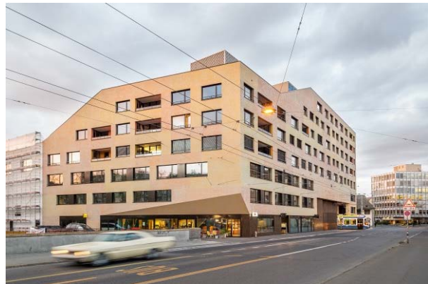
Neubau an der Kalkbreitestrasse Bild: M. Egloff
