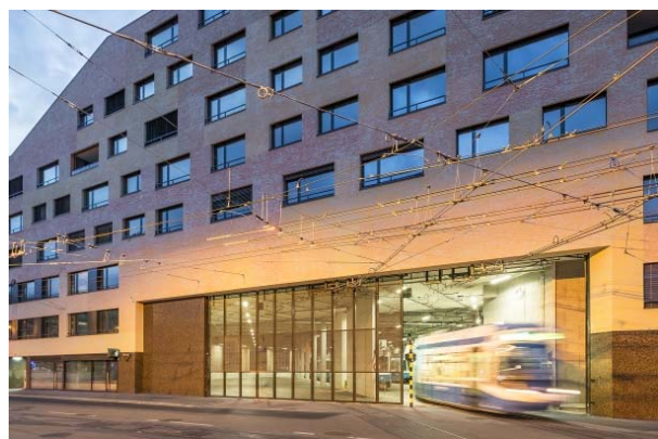
Wohnen über der Tramhalle Bild: M. Egloff
