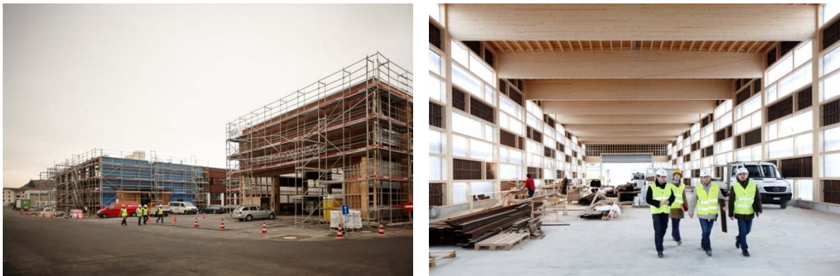
Abbildung 1: Neubau Werkhof Sprengi, Bundesamt für Strassen ASTRA, Emmenbrücke
