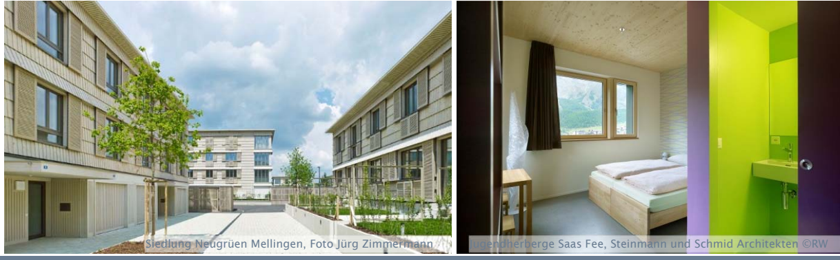
Abbildung 16: Fenster, Fassade und Innenraum in Holz am Beispiel Wohnen und Beherbergung
