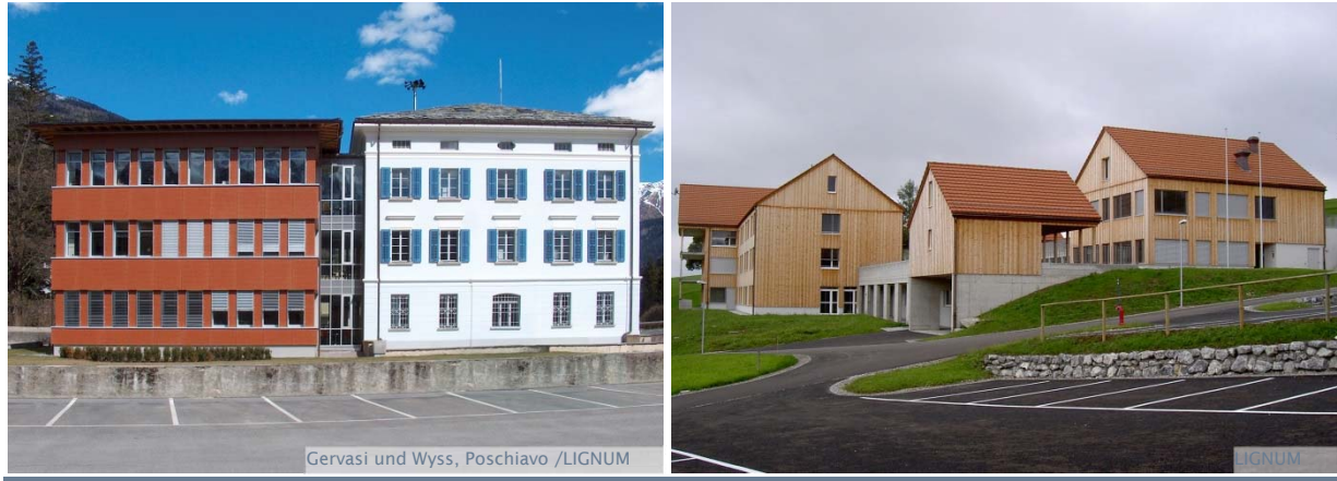
Abbildung 25: Materialentscheidung bei der Fassade
